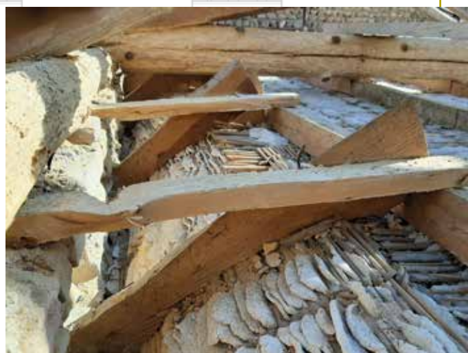
Consolidamento del controsoffitto della chiesa
