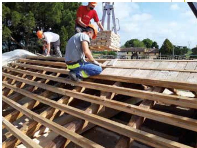
Riposizionamento delle tavelline originarie
